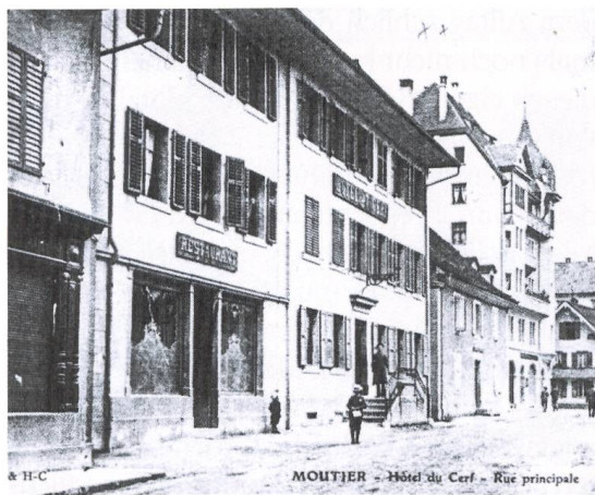
Abb. 37 Das Hotel und Restau- rant du Cerf an der Rue principale in Moutier, auf der linken Strassenseite, um 1908, als die Familie Villinger den Betrieb führte. Im Vordergrund das Re- staurant, dahinter mit Treppe das Hotel. Ob die Personen vor dem Hotel Familienan- gehörige sind, kann nicht beurteilt werden. (Musée d'Histoire, Moutier)
