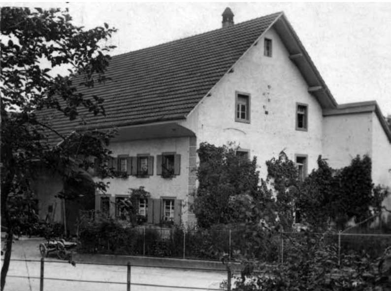
Das Bauernhaus an der Schupfarterstrasse 9 im Jahre 1950. Die ursprüngliche Bauform dieses Hauses hat sich bis in die Gegenwart erhalten. (Bild: zVg Gerhard John)
