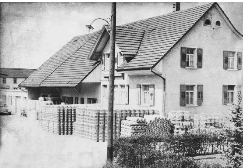
1960 musste die Firma Dinkel aus Platzgründen die Produkte auf dem Vorplatz zwischengelagern. Es folgten stetige Erweiterungen der Produktions- und Lagerräume.
