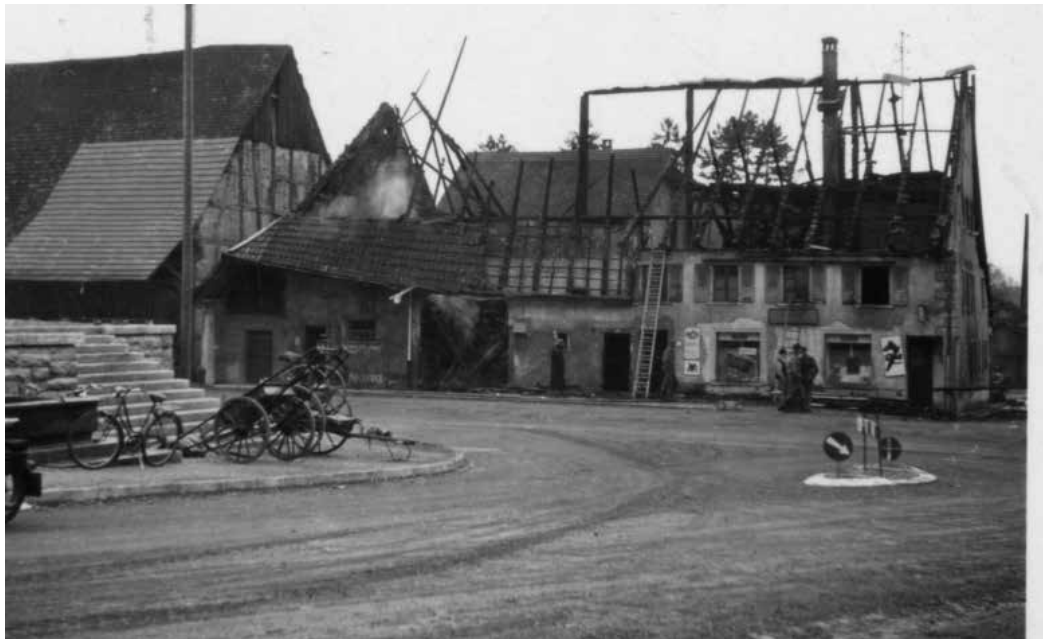
1957 brannte das Haus der Handlung Jegge mitten im Dorf nieder. Der Neubau mit Bäckerei, Tea Room und Lebensmittelladen veränderte den Dorfkern markant. (Bild: zVg Andrea Jegge)
