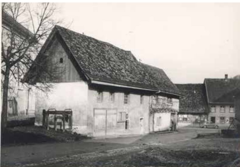
Das sogenannte Armenhaus mit angebauter Schmiede (rechts). Links an der Giebelwand der «Notstand». Er diente dem Beschlagen der Stiere und Kühe, die als Zugtiere gebraucht wurden.
