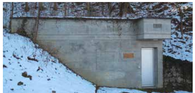
Das Stufenpumpwerk der Gemeinde Schupfart an der Seckenbergstrasse. (Foto: Hermann Schweizer)
