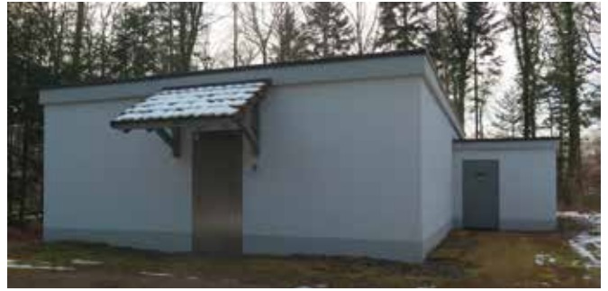
Pumpwerk im Hardwald. (Foto: Hermann Schweizer)
