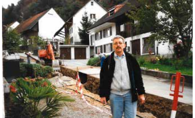
Gemeinderat Peter Baumgartner (†) bei der Besichtigung der Baustelle «Wasserleitung NW 200» im Oberdorf. (Bild: zVg Hermann Schweizer)
