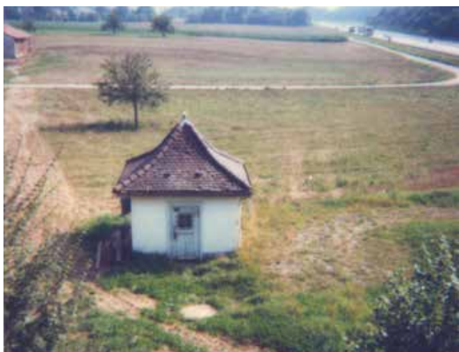
Das 1947 in Betrieb genommene Pumpwerk in der Bläie (heute abgerissen). (Bild: zVg Hermann Schweizer)
