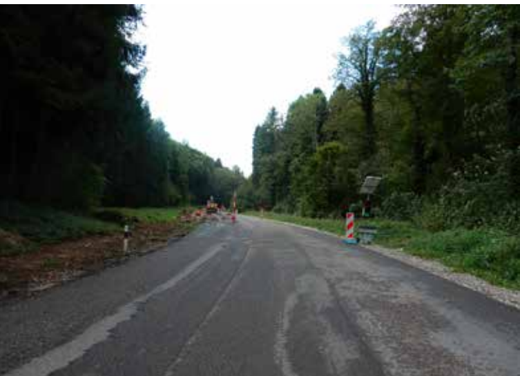
Bauarbeiten an der Strasse nach Schupfart im August 2017. (Foto: Hermann Schweizer)
