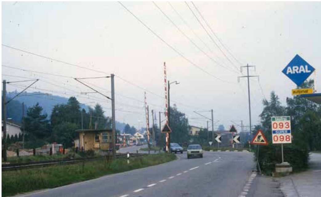
Im Herbst 1986 konnte der Bahnübergang im Ausserdorf durch eine Unterführung ersetzt werden. Nicht selten mussten die Schranken für zwei bis drei Zugsdurchfahrten geschlossen werden, so dass sich lange Autoschlangen bis in die Dorfmitte bildeten. Die für den Durchgangsverkehr gesperrte Stettenenstrasse wurde zur begehrten Ausweichroute insbesondere Richtung Autobahn. (Foto: Urs Berger, Oktober 1986)
