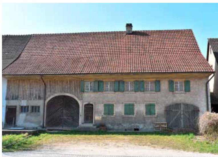
Das Bauernhaus an der Hauptstrasse 24 im März 2019. Seit mehr als einem halben Jahrhundert repräsentiert der Bau unverändert die schlichte Bauweise mit den kleinen Fenstern. (Foto: Urs Berger)
