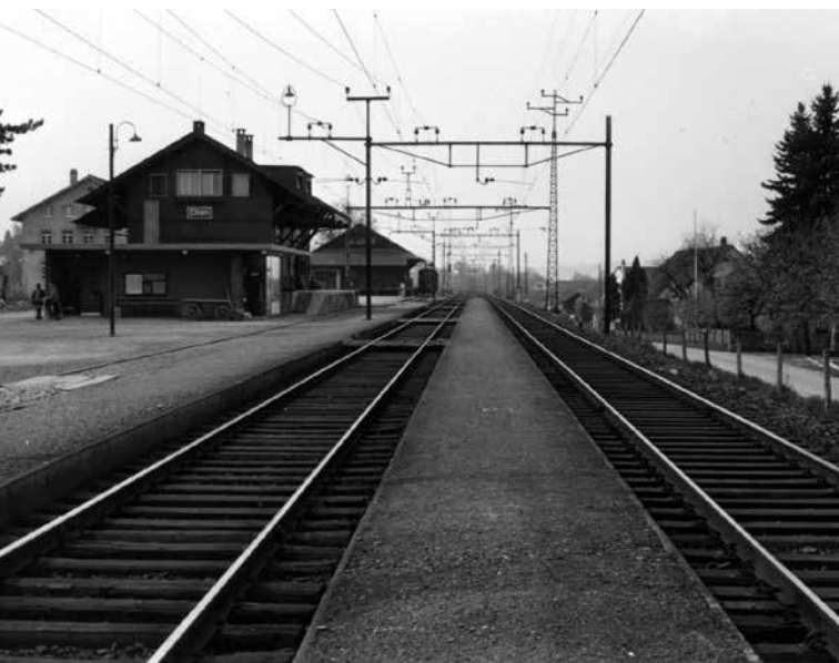
Der Bahnhof Eiken kurz nach der Erweiterung mit Wartesaal, Toiletten und neuem Büro mit Stellwerk im Jahre 1962. Kurze Zeit später folgte der Ersatz des Mittelperrons durch einen zweiten Aussenperron und eine Unterführung. (Bild: zVg Karl John, Frick)
