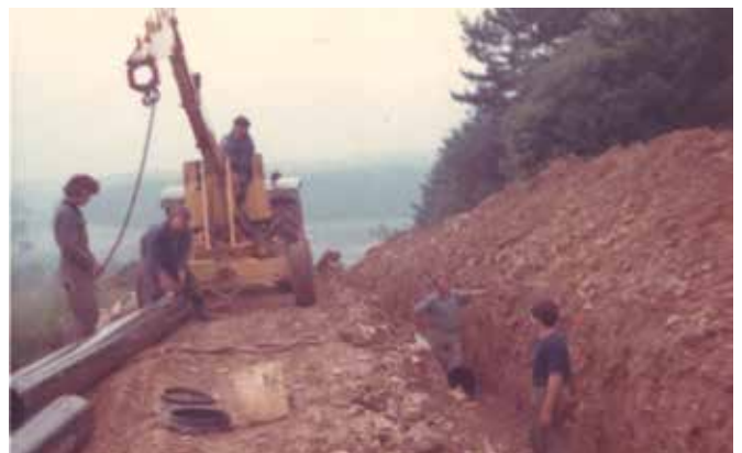
Verlegen der NW 300 HD Gussröhren beim Jagdhaus Hubertus 1973. (Bild: zVg Hermann Schweizer)
