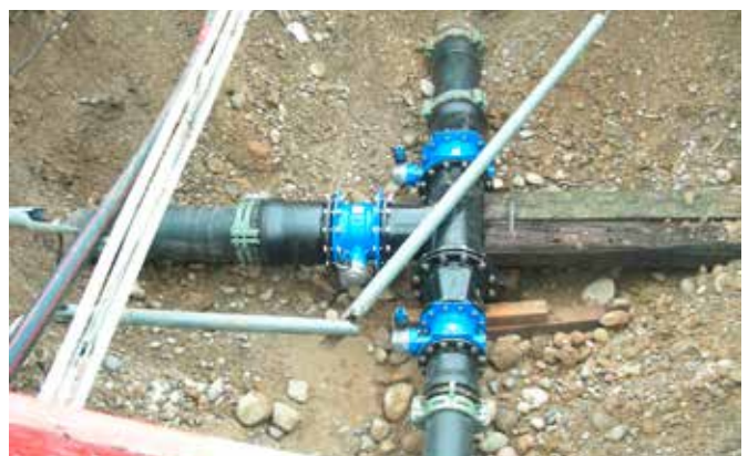
Einbau von drei Klappen, zwei NW 300 und eine NW 200, am Hinter Elenberg am 24. Oktober 2010 in Nachtarbeit verlegt. (Foto: Hermann Schweizer)
