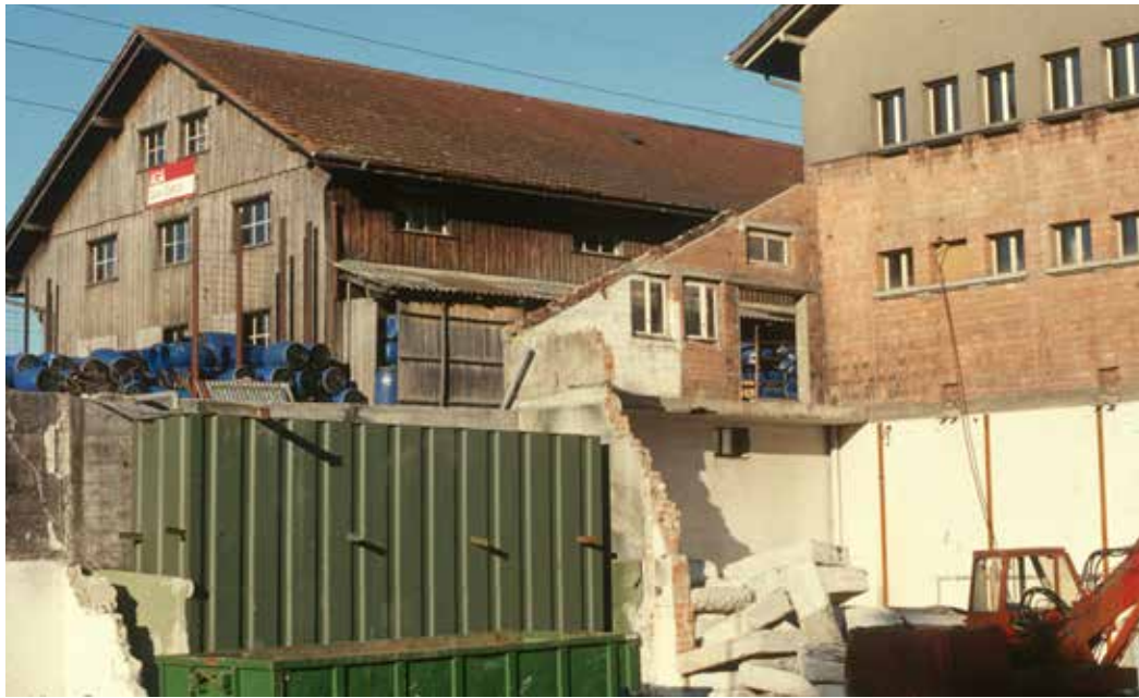
Im Mai 2000 wurde bei der heutigen Landi die einstige Schnapsbrennerei abgebrochen, wenig später das hölzerne Lagerhaus für Futtermittel. Der grüne Öltank diente im einstigen Kohlenbunker der 1974 eingeführten Ölfeuerung für die Dampferzeugung der Brennöfen. (Foto: Urs Berger)
