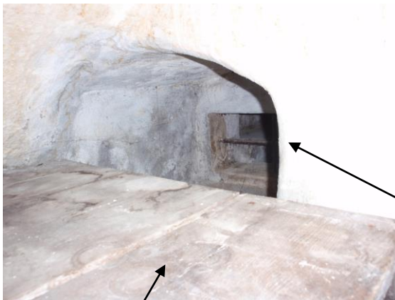
Holzhurde im Keller
